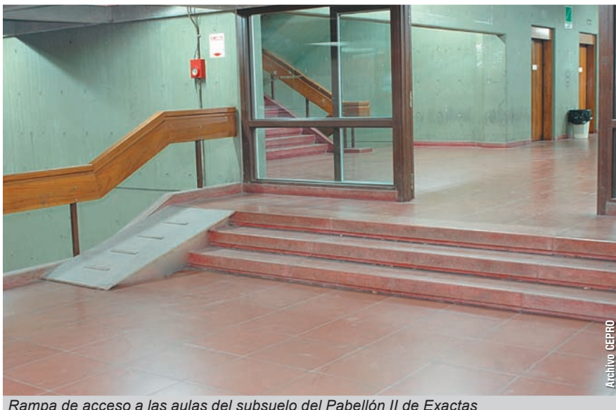
Rampa de acceso a las aulas del subsuelo del Pabellón II de Exactas
