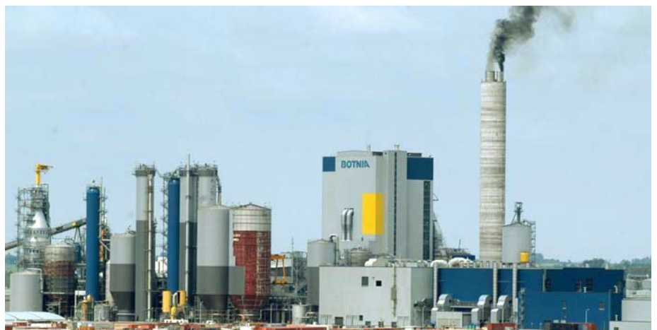
El humo negro que despidió la chimenea señaló la puesta en marcha de la planta, el último fin de semana.
